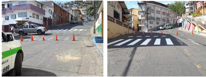
APOYO A EMPRESA ELECTRICA CENEL POR CAMBIO DE POSTES
