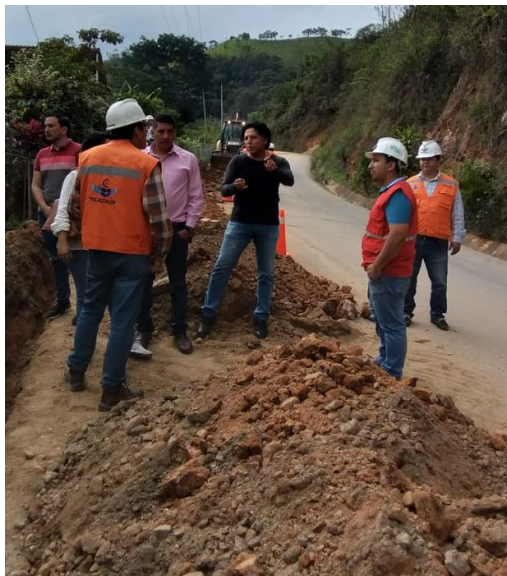
Fiscalización de la obra de Agua Potable y Alcantarillado
